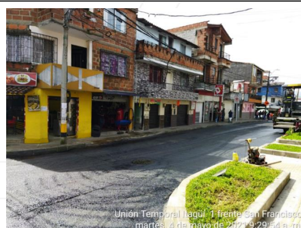
APLICACIÓN DE RIEGO DE LIGA CON EMULSIÓN ASFÁLTICA EN LA CALLE 27 ENTRE CARRERA 70 Y 65.
