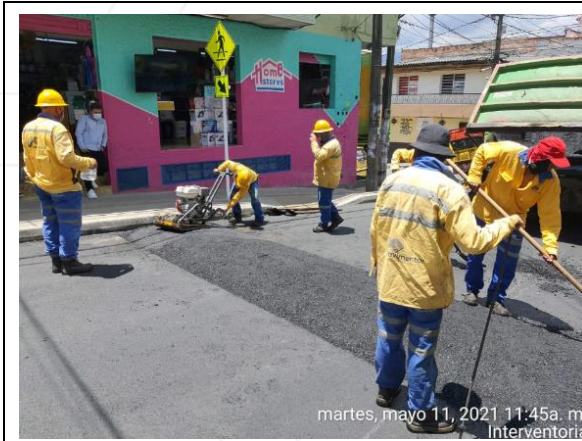
CONSTRUCCIÓN DE RESALTO EN LA CALLE 27, SECTOR SAN FRANCISCO.
