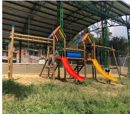
INSTALACIÓN DE PARQUE INFANTIL
