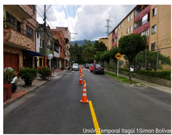
PINTURA VIAL PARA DEMARCACIÓN Y LÍNEA CENTRAL.
