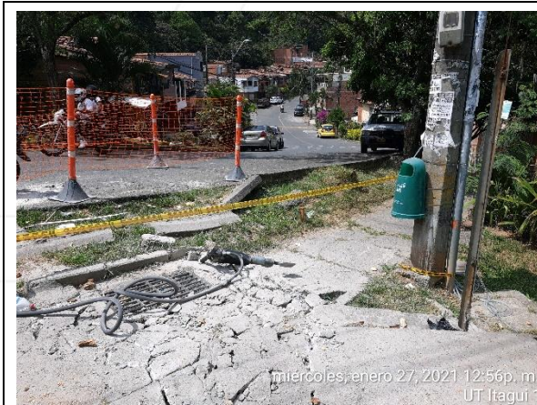
ZONA PLAZOLETA ANTES
