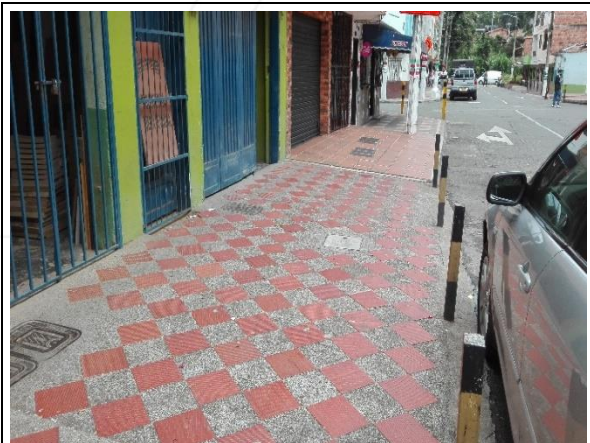
ANDÉN CALLE 46 ENTRE CARRERAS 53-54(ANTES).
