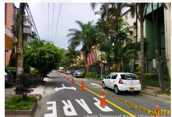
PINTURA VIAL PARA DEMARCACIÓN Y LÍNEA CENTRAL.
