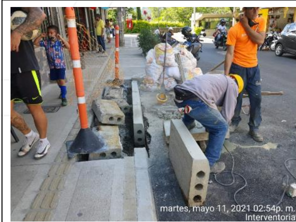
RESTITUCIÓN DE ANDÉN AL LADO DE BAHÍA.
