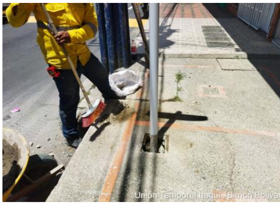
INSTALACIÓN DE SEÑAL VERTICAL.
