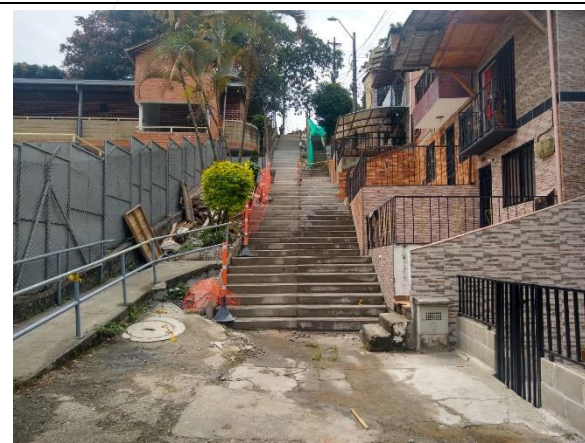
ESCALAS Y RAMPA ANTES
