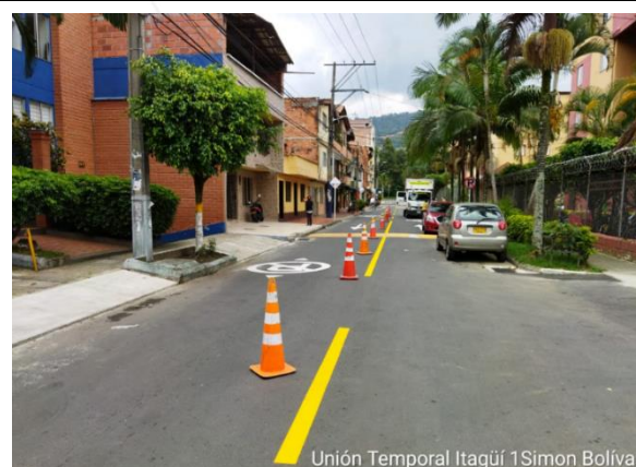
PINTURA VIAL PARA DEMARCACIÓN Y LÍNEA CENTRAL.
