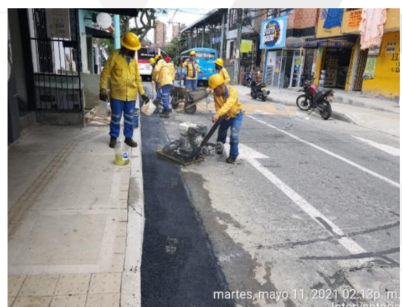
PARCHEO DE BORDE DE VÍA - AJUSTE DE PAVIMENTO CONTRA CORDÓN EN LA CALLE 27 ENTRE CARRERAS 64ª Y 65.
