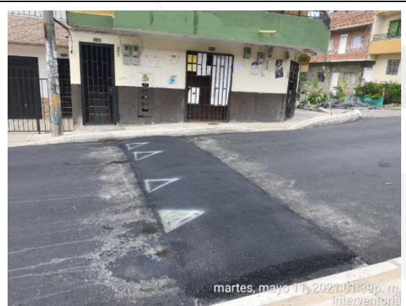
CONSTRUCCIÓN DE RESALTO EN LA CALLE 27, SECTOR SAN FRANCISCO.
