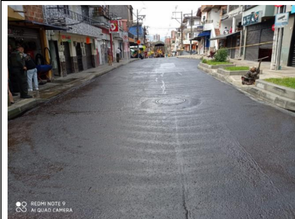
APLICACIÓN DE RIEGO DE LIGA CON EMULSIÓN ASFÁLTICA EN LA CALLE 27 ENTRE CARRERA 70 Y 65.
