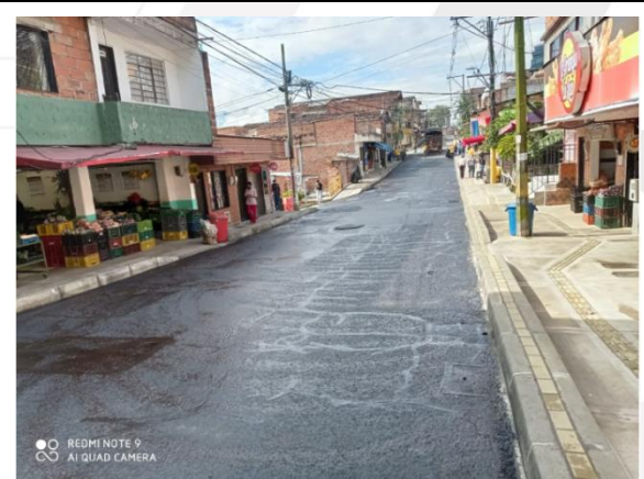
APLICACIÓN DE RIEGO DE LIGA CON EMULSIÓN ASFÁLTICA EN LA CALLE 27 ENTRE CARRERA 70 Y 65.
