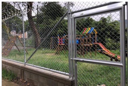
MTTO PARQUE Y CONSTRUCCIÓN DE CERRAMIENTO
