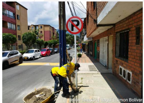
INSTALACIÓN DE SEÑAL VERTICAL.
