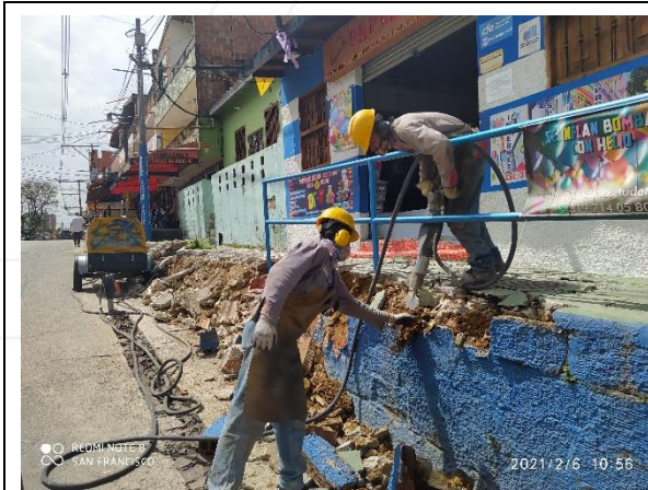
ANDÉN CLL 27 ENTRE CRAS 65-66 COSTADO SUR-OCCIDENTAL.(ANTES)
