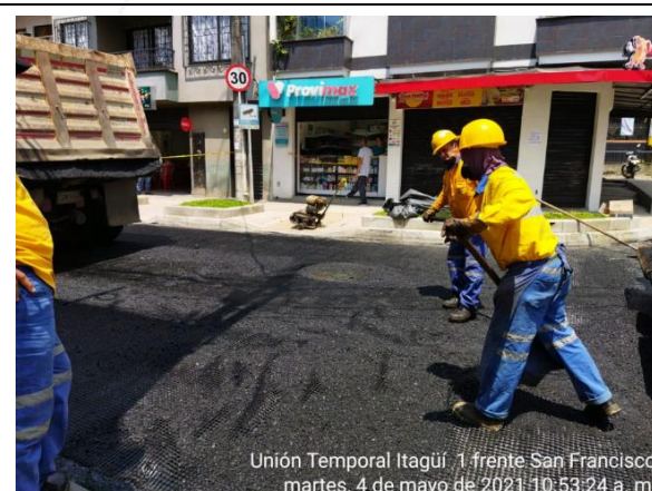
COLOCACIÓN DE GEOMALLA SOBRE CARPETA EXISTENTE EN LA CALLE 27 ENTRE CARRERA 70 Y 65.
