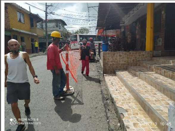
ANDÉN CLL 27 ENTRE CRAS 65-66 COSTADO SUR-OCCIDENTAL.(ANTES)
