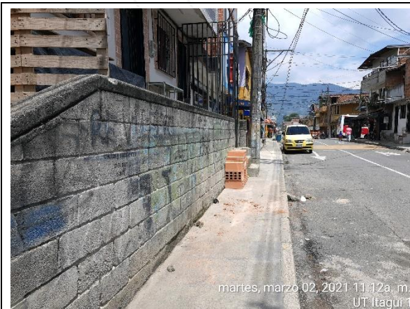
ANDÉN CLL 27 ENTRE CRAS 64ª-65 COSTADO SUR-OCCIDENTAL.(ANTES)
