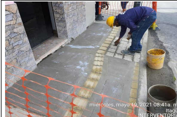
REPARACIÓN DE ANDENES CON FISURAS.
