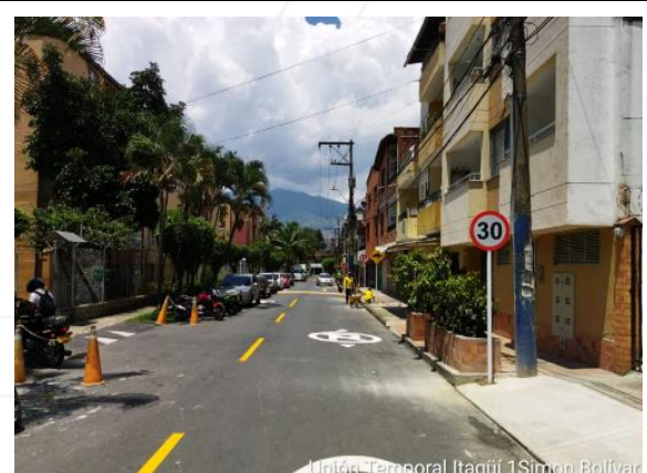
PINTURA VIAL PARA DEMARCACIÓN Y LÍNEA CENTRAL.
