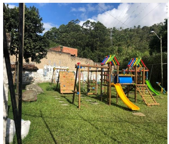
INSTALACIÓN DE MÓDULOS PARA COMPLEMENTO
