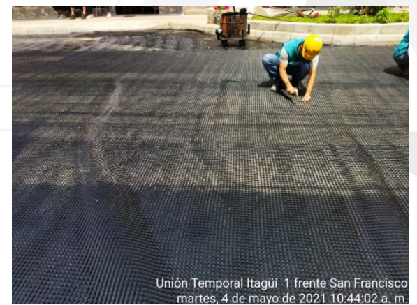
COLOCACIÓN DE GEOMALLA SOBRE CARPETA EXISTENTE EN LA CALLE 27 ENTRE CARRERA 70 Y 65.
