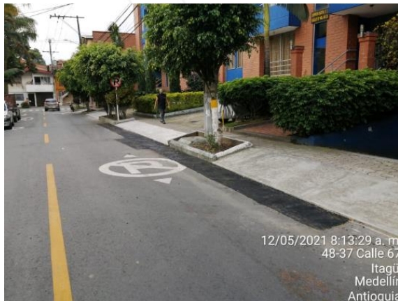
COLOCACIÓN DE MDC-19 PARA NIVELACIÓN EN LA CALLE 67 ENTRE CARRERA 48 Y 52- FRENTE SIMÓN BOLÍVAR
