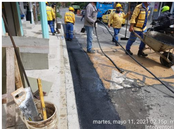
AJUSTE DE PAVIMENTO CONTRA CORDÓN Y NIVELACIÓN EN LA CALLE 27.
