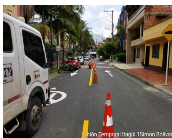
PINTURA VIAL PARA DEMARCACIÓN Y LÍNEA CENTRAL.
