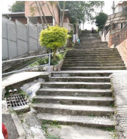
ESCALAS Y RAMPA ANTES
