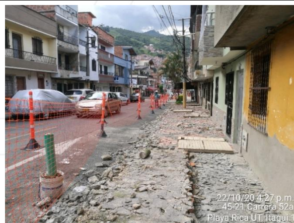
ANDÉN CALLE 45A ENTRE CARRERAS 52A-53(ANTES).
