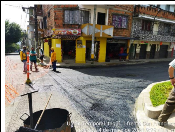
APLICACIÓN DE RIEGO DE LIGA CON EMULSIÓN ASFÁLTICA EN LA CALLE 27 ENTRE CARRERA 70 Y 65.
