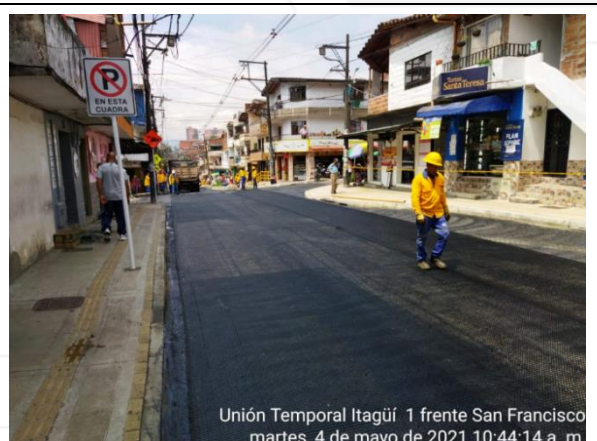
COLOCACIÓN DE GEOMALLA SOBRE CARPETA EXISTENTE EN LA CALLE 27 ENTRE CARRERA 70 Y 65.
