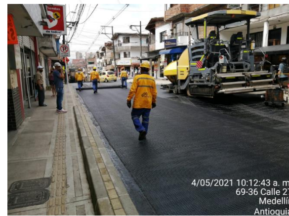
COLOCACIÓN DE GEOMALLA SOBRE CARPETA EXISTENTE EN LA CALLE 27 ENTRE CARRERA 70 Y 65.
