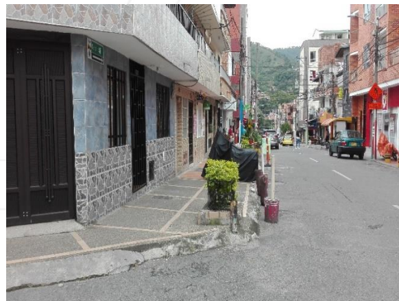
ANDÉN CALLE 46 ENTRE CARRERAS 52A-53. (ANTES).
