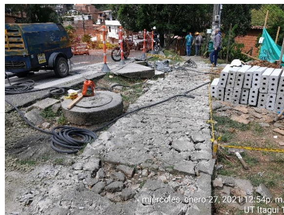
ZONA PLAZOLETA ANTES
