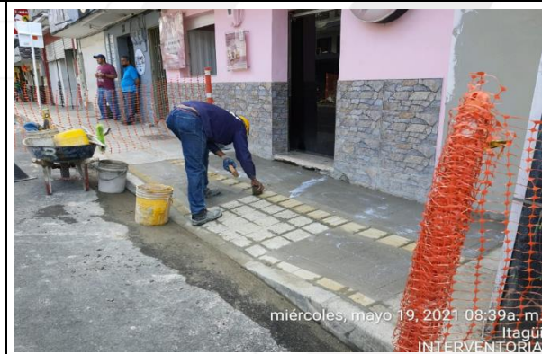
REPARACIÓN DE ANDENES CON FISURAS.
