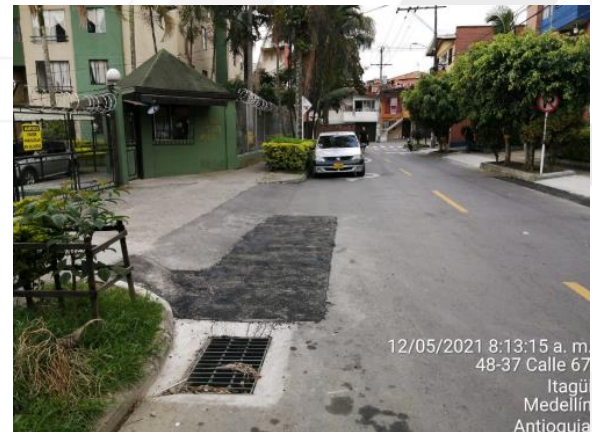
COLOCACIÓN DE MDC-19 PARA NIVELACIÓN EN LA CALLE 67 ENTRE CARRERA 48 Y 52- FRENTE SIMÓN BOLÍVAR
