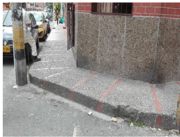
ANDÉN CALLE 46 ENTRE CARRERAS 52-52ª (ANTES).
