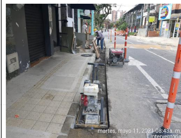
PARCHEO DE BORDE DE VÍA - AJUSTE DE PAVIMENTO CONTRA CORDÓN EN LA CALLE 27 ENTRE CARRERAS 64ª Y 65.
