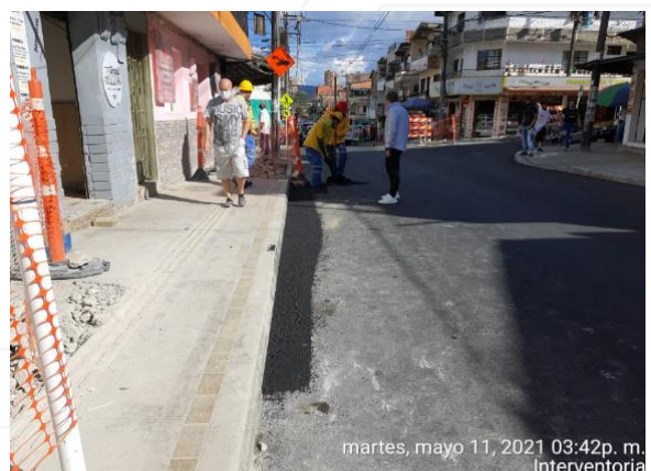
AJUSTE DE PAVIMENTO CONTRA CORDÓN Y NIVELACIÓN EN LA CALLE 27.
