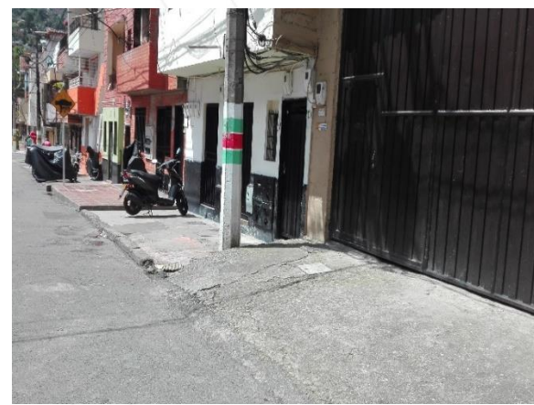
ANDÉN CALLE 45A ENTRE CARRERAS 53-54 (ANTES).
