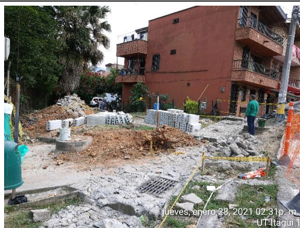
ZONA PLAZOLETA ANTES
