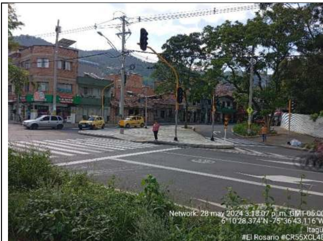
Instalación del cruce semafórico de la Calle 48 con carrera 55 El Rosario
