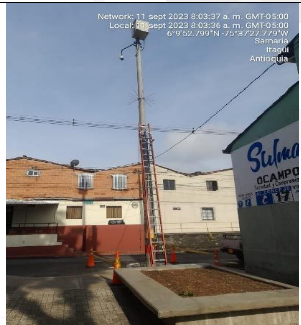
Cámara 42 cancha Samaria
