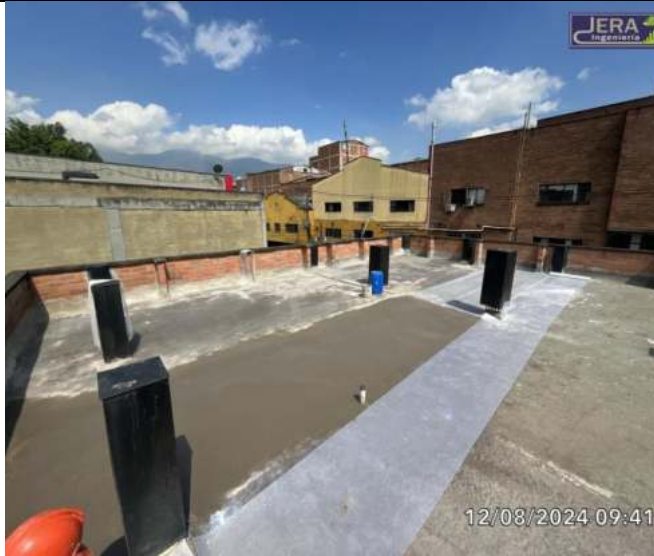
Impermeabilización de losa de cubierta. - Secretaría de Movilidad
