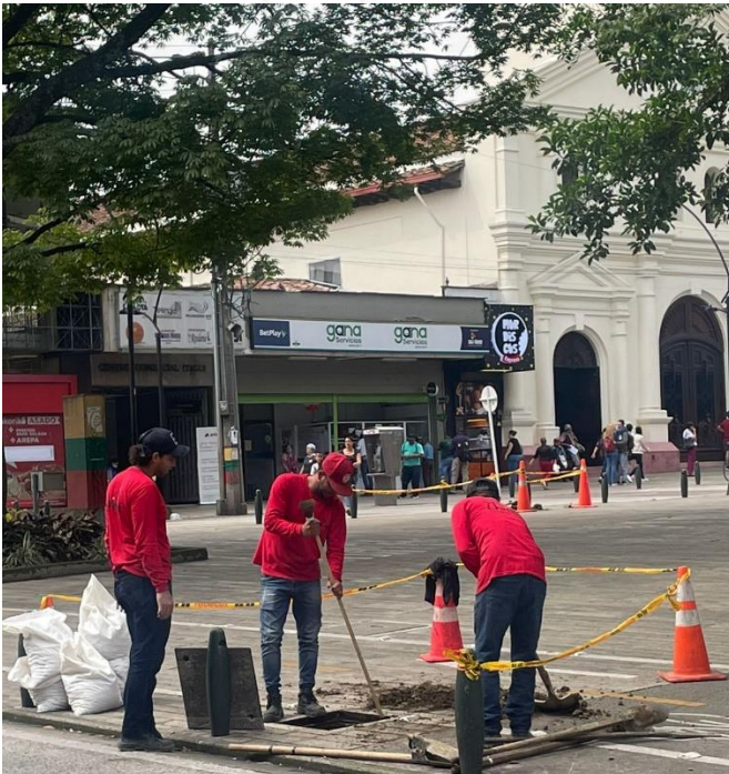
EXCAVACIÓN PARA INSTALACIÓN DE POSTES
