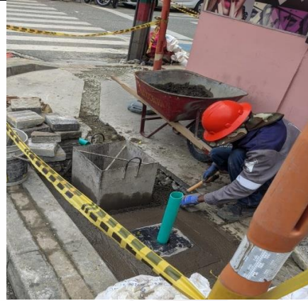
Actividades en la ampliacion Carrera 50 X calle 53 (Adición)
