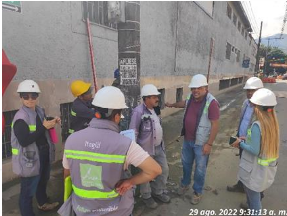
RECORRIDOS DE OBRA
