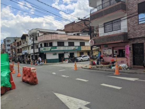
Actividades en la ampliacion Carrera 49 X calle 53 (Adición)
