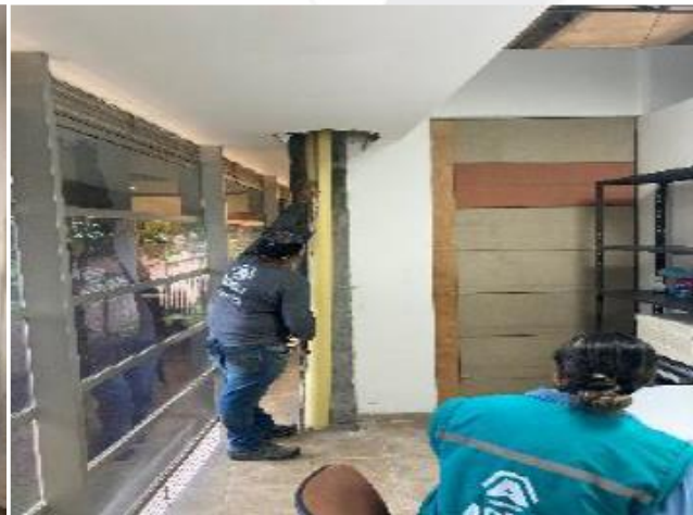
CAMBIO DE BAJANTES DE AGUAS LLUVIAS EN CASA DE LA JUSTICIA
