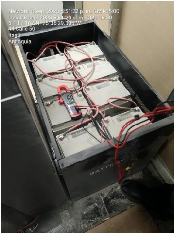
Mantenimiento a UPS del CCM
