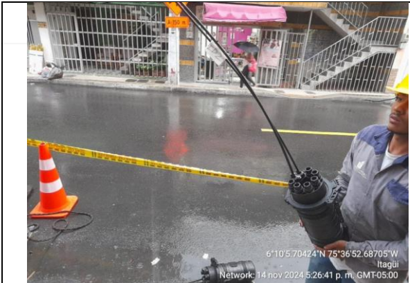
Reparación de fibra óptica
