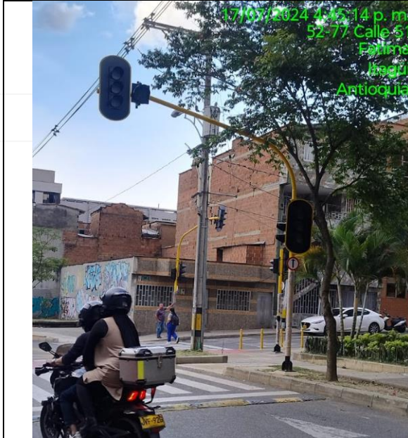
Instalación de semáforo en la Carrera 53 y 53A X Calle 51
