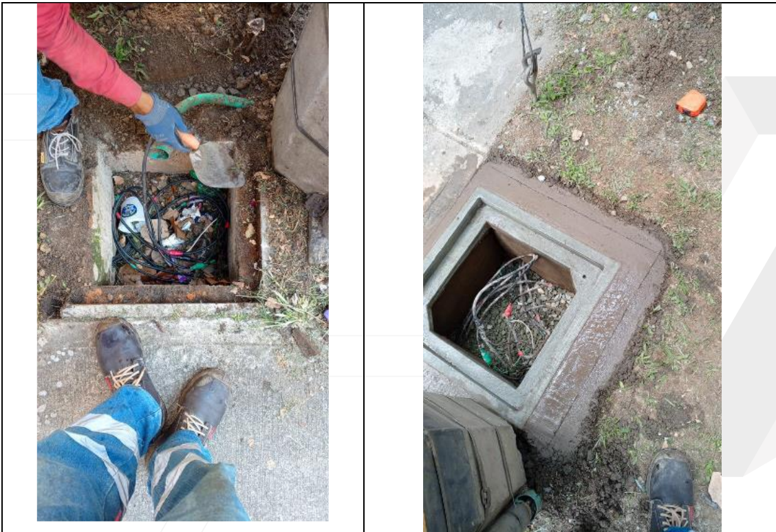
Ciudadela del Valle: Mantenimiento Preventivo redes subterráneas
