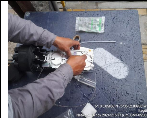
Empalmería de la fibra reventada
