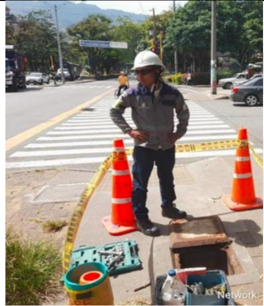
Mantenimiento correctivo del cruce de la central mayorista
