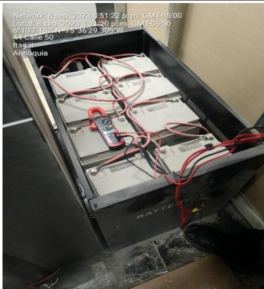
Mantenimiento a la UPS del centro de control y monitoreo CCM
