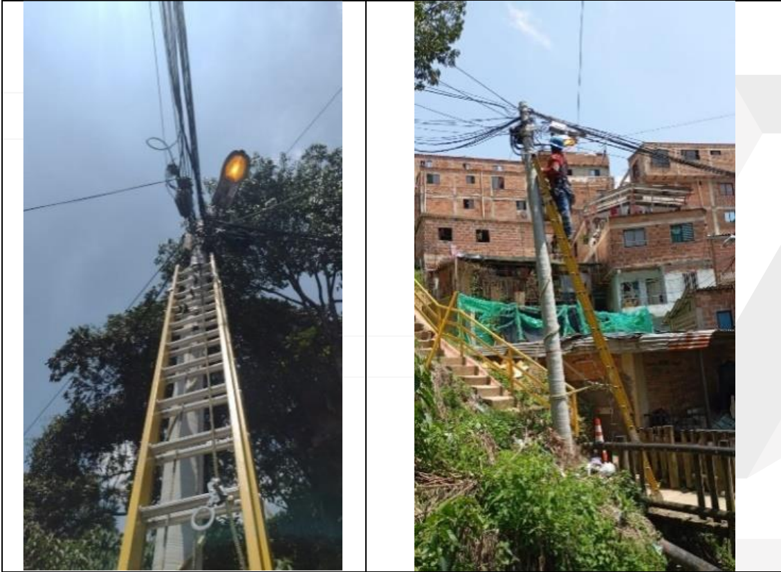
Vereda el Ajizal: Reparación de Luminarias Encendidas
