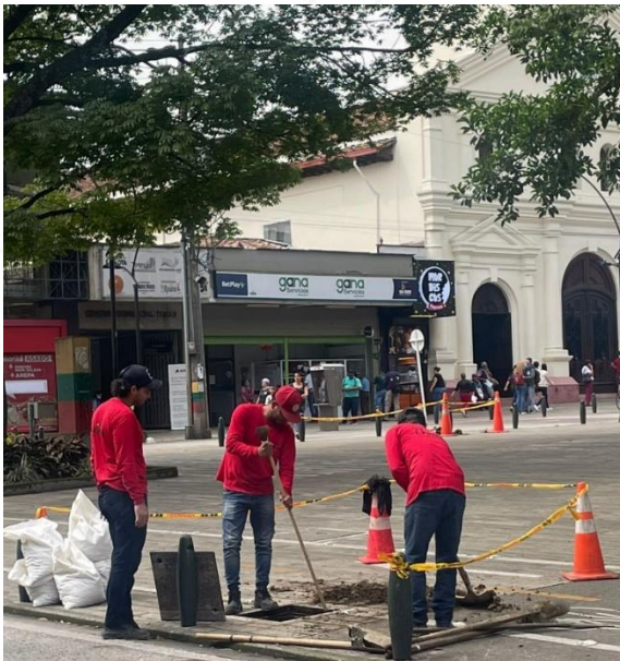
EXCAVACIÓN PARA INSTALACIÓN DE POSTES
