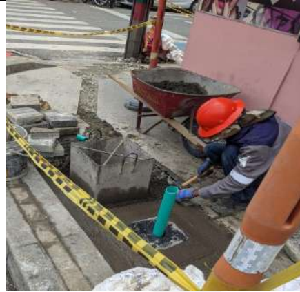
Actividades en la ampliación Carrera 50 X calle 53 (Adición)
