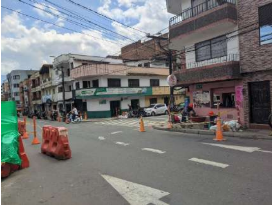
Actividades en la ampliación Carrera 49 X calle 53 (Adición)
