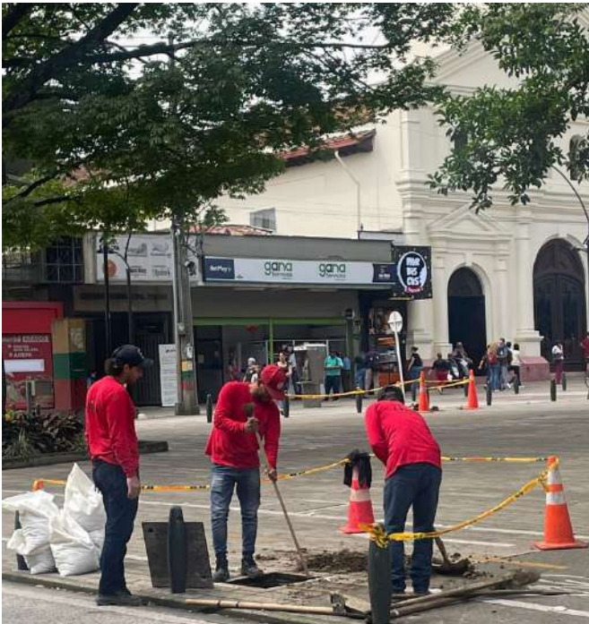
EXCAVACIÓN PARA INSTALACIÓN DE POSTES
