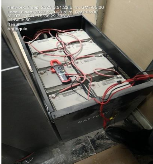
Mantenimiento a la UPS del centro de control y monitoreo CCM
