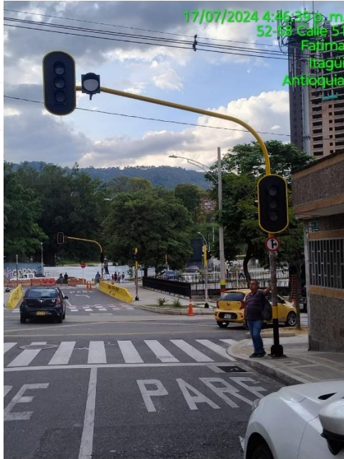
Instalación del cruce semafórico de la Calle 51 con carreras 55 y 53 a
