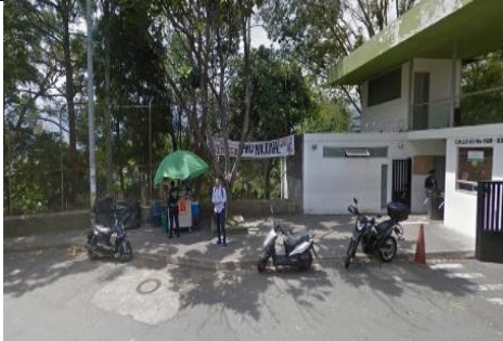
Mejoramiento de andenes Calatrava (antes)
