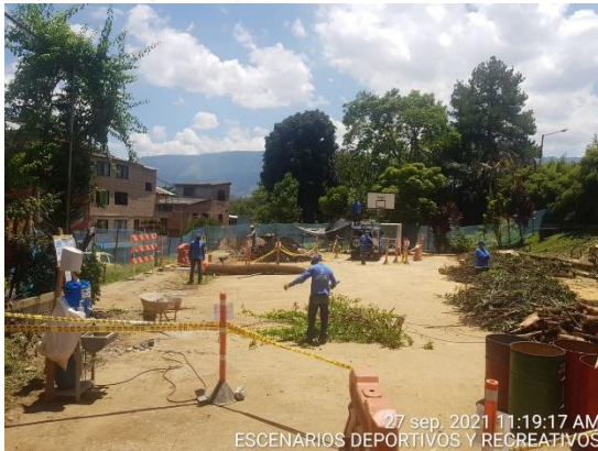
Construcción de Cubierta Placa La Aldea
