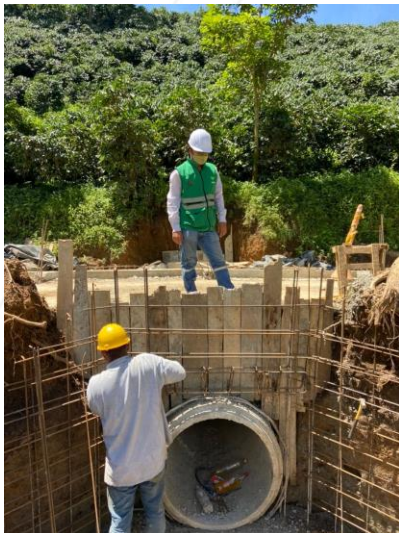
Proceso Constructivo Obra Transversal
