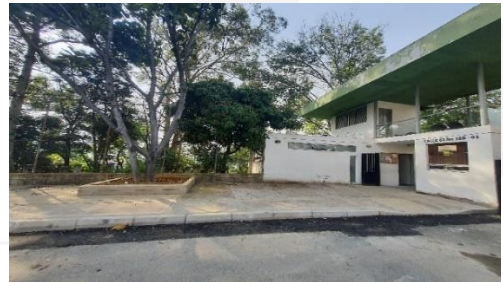
Mejoramiento de andenes Calatrava (después)
