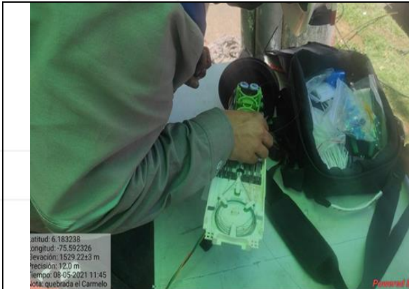
Mantenimiento correctivo en muflas de la red de fibra óptica
