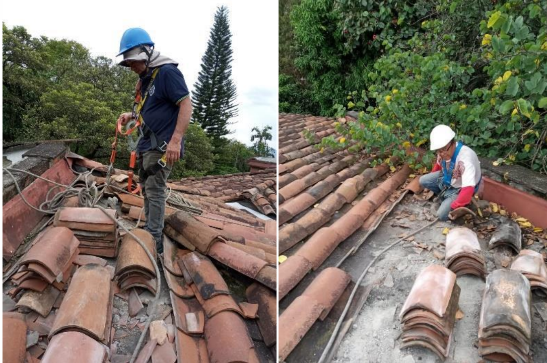
MANTENIMIENTO DE CUBIERTAS EN COLTEJER
