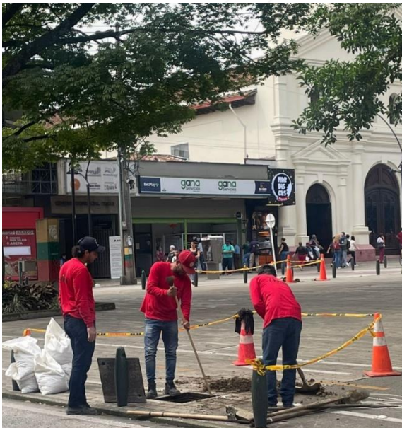
EXCAVACIÓN PARA INSTALACIÓN DE POSTES
