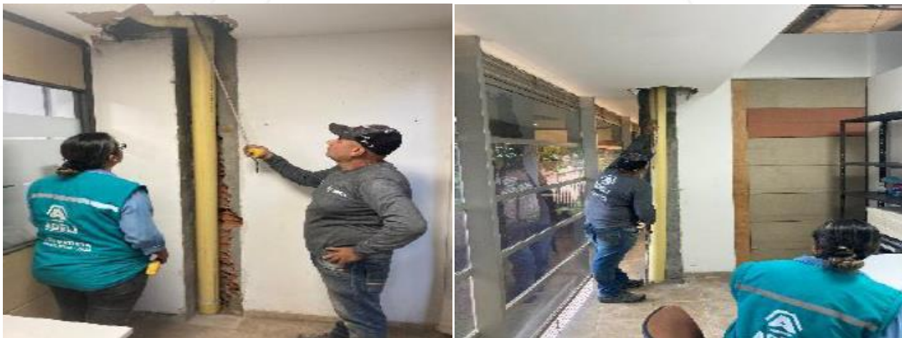
CAMBIO DE BAJANTES DE AGUAS LLUVIAS EN CASA DE LA JUSTICIA
