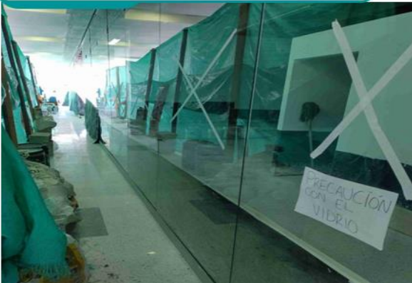
INSTALACIÓN DE FACHADA EN VIDRIO PARA LAS OFICINAS
